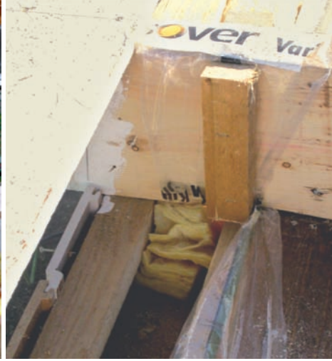
Bild 4 (links): Nicht nur historische Gebäude sind betroffen. Nachträgliche Erstellung einer luftdichten Gebäudehülle an einer nur wenige Jahre alten Reihenhausanlage. Die Ausbildung der Randanschlüsse mittels Kompriband, Klebeband und Andruckleisten erfordert zeitaufwendige Detailarbeiten nach entsprechender Planung. Bild 5 (Mitte): Detail des Anschlusses Balken/Pfette. Bild 6 (rechts): Detail des luftdichten Anschlusses an den Balkenkopf.
