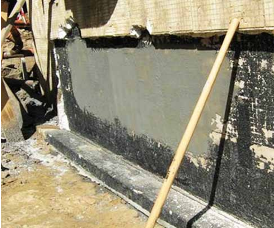
Haftbrücke mit kunststoffmodifizierter Dichtungsschlämme (MDS).
