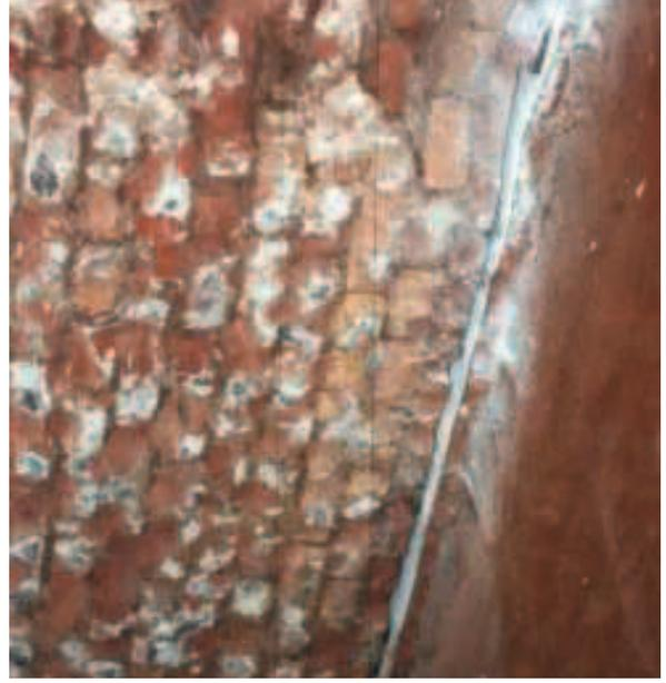
fertige Horizontalsperre – Mauer sägeverfahren
