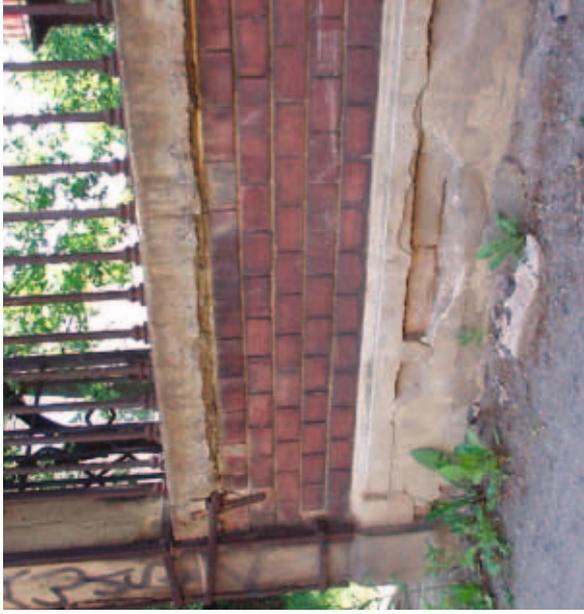
Bauschäden können an Holz (z.B. Fachwerk), Stein (z.B. Mauerwerk), Stein (z.B. Mauerwerk) oder Putz entstehen. Eindringende Feuchtigkeit ist die Hauptursache dafür.
